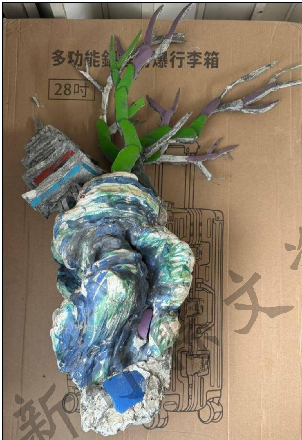
北港朝天宮三川殿剪粘出現斷裂掉落
