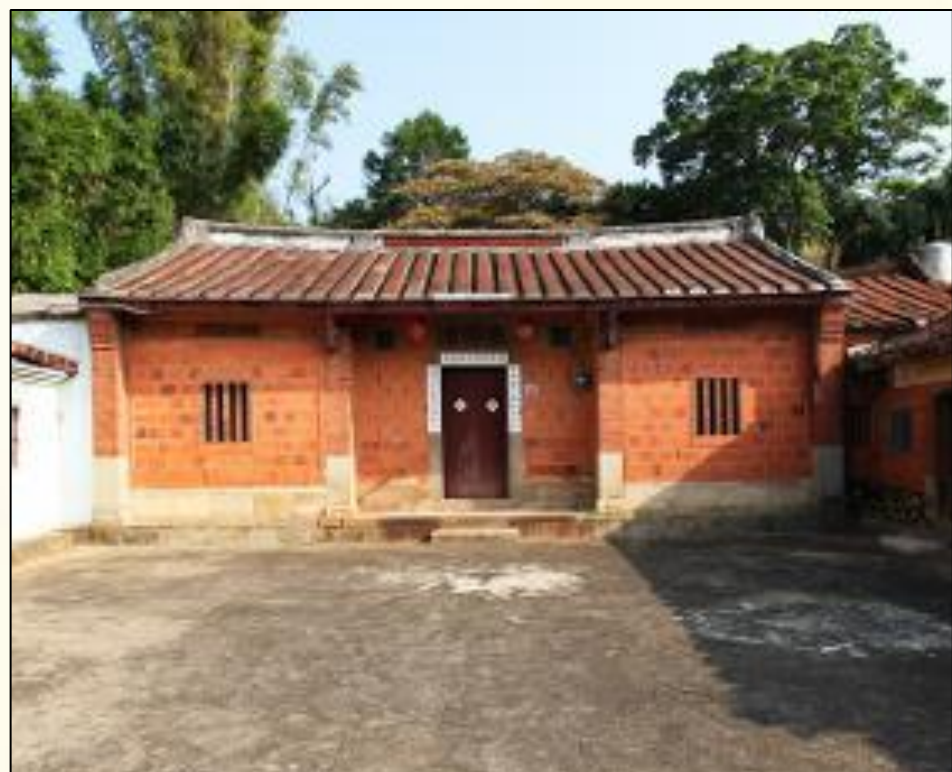
關西南陽堂鄧屋 (歷史建築)
