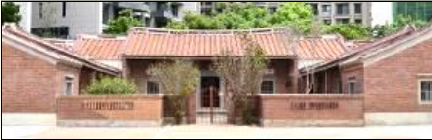
竹北泉州厝汾陽堂 (歷史建築)
