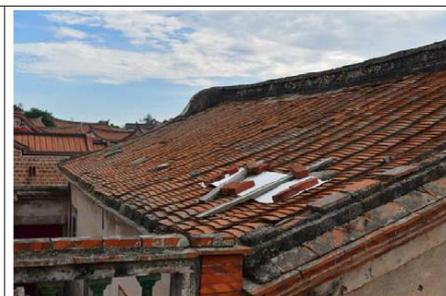
說明：中落後坡屋面破損滲水
