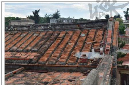
說明：前落後坡右側屋面破損多處
