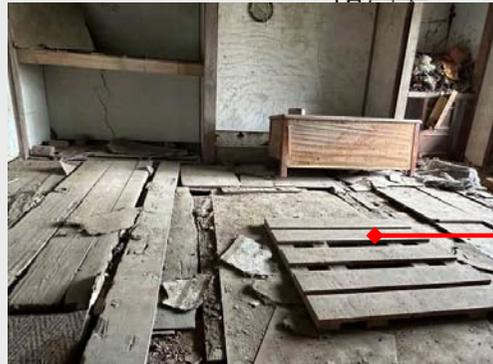
結構崩塌，木構腐朽
