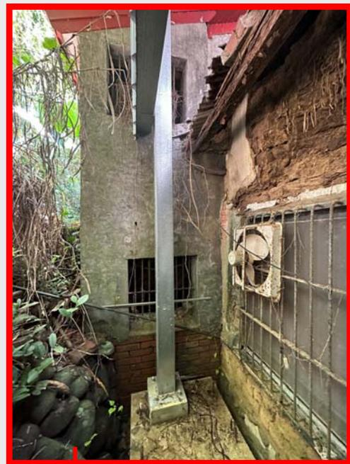
➤ 原有明溝排水系統被後期增建阻隔
