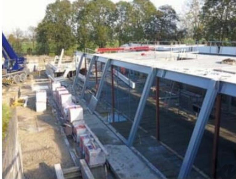
Nieuwbouw staalconstructie begane grond met betonnen dak aan de wellnesszijde.
