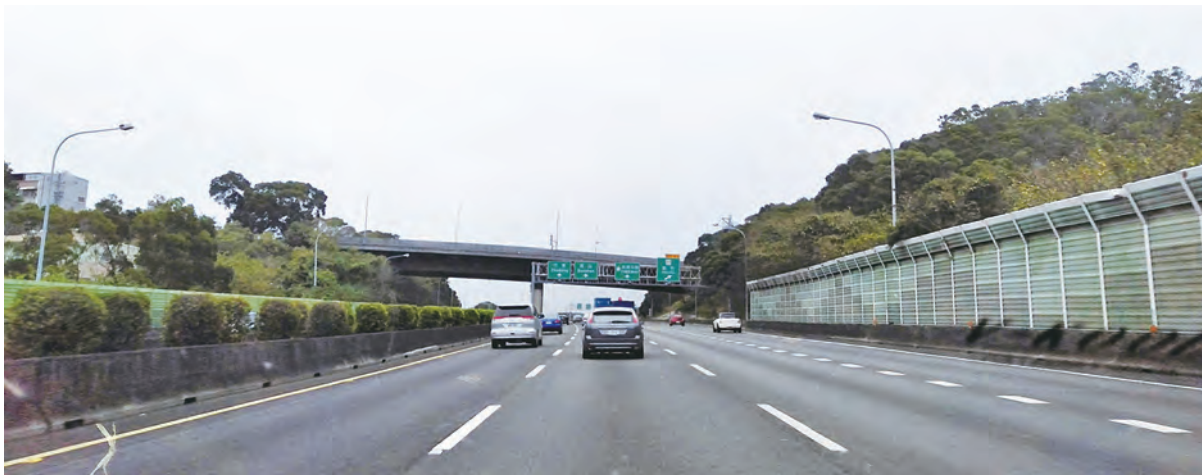
圖 5-3-2 新竹路段國 1 高速公路
