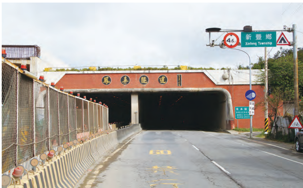
圖 5-3-6 臺 15 線鳳鼻隧道北端
