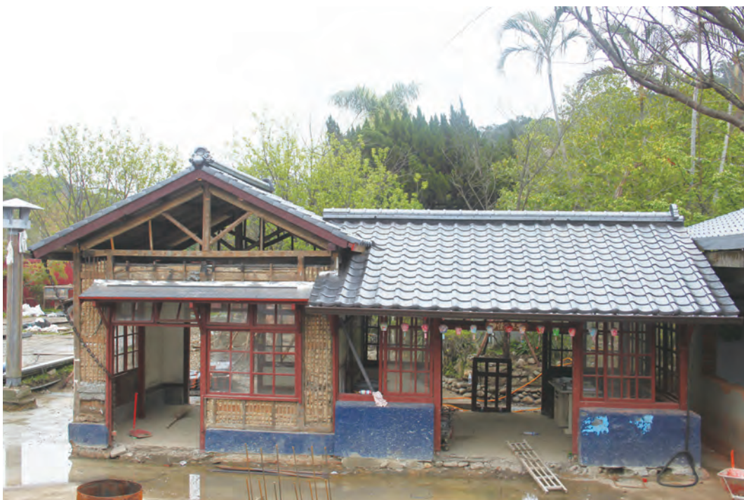
圖 5-2-18 整修中的合興車站候車室
