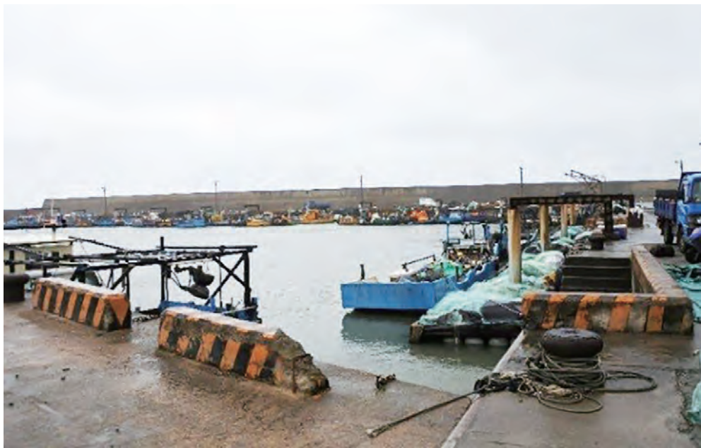
圖 1-3-3 坡頭漁港設施
