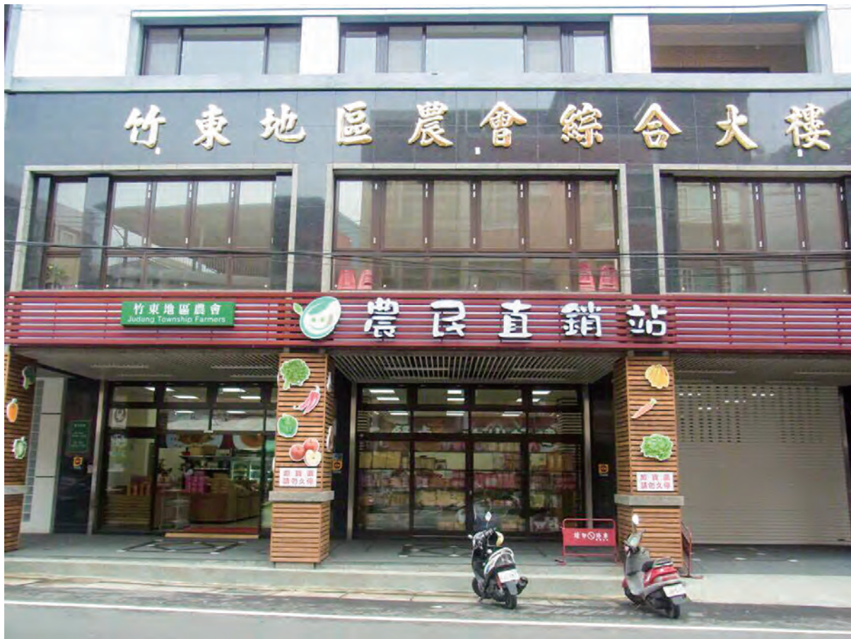
圖 1-1-7 竹東地區農會綜合大樓外觀及農民直銷站
