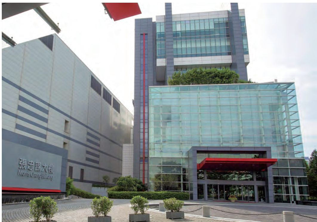
圖 6-4-1 臺積電張忠謀大樓
