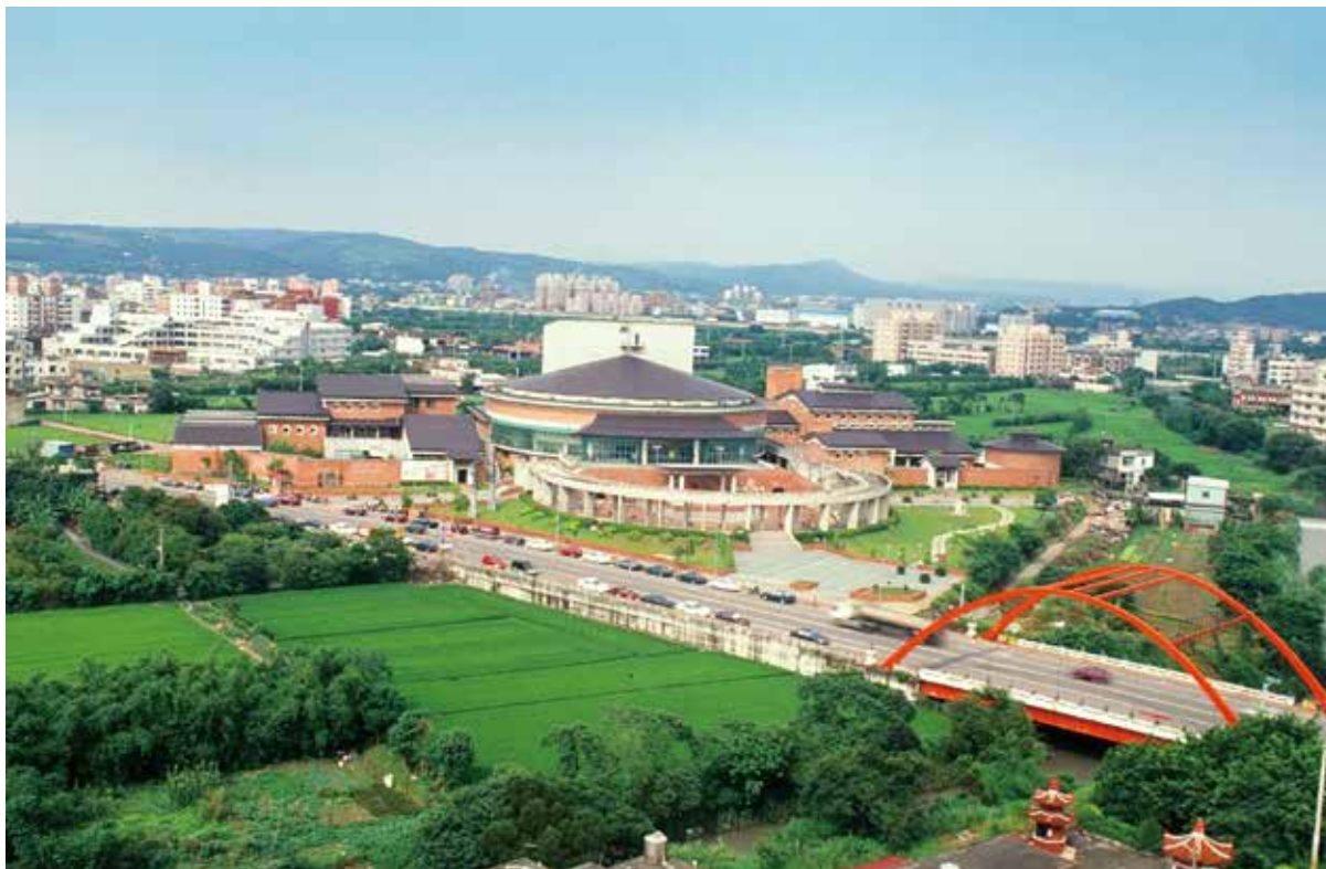
圖 1-2-6 文化中心竣工，但旁邊的荳子埔溪尚未整治，對面之公園還為一片樹林與稻田
