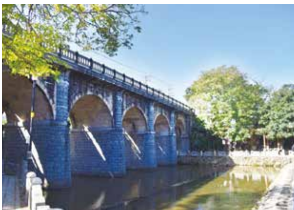
圖 6-2-24 關西東安古橋
