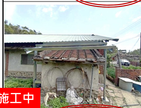
8. 外廁所屋頂保護鋼架 2.3M*3.4M
