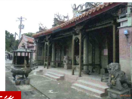
三川殿前檐緊急支撐施工後
