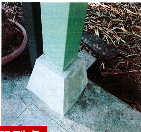
局部修補開裂處
