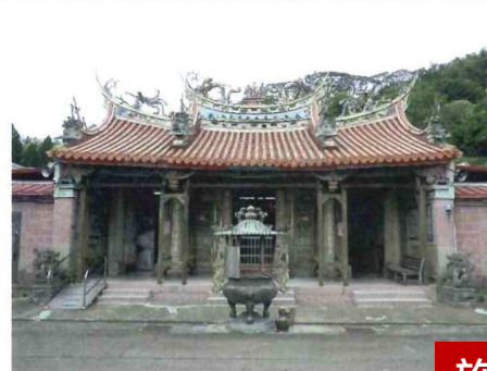
三川殿前檐緊急支撐施工後
