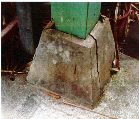
局部修補開裂處
