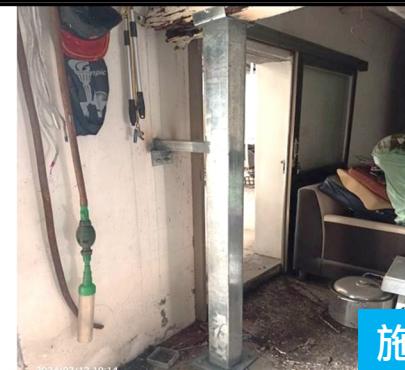
7. 右稍間、盡間補強 C 型鋼雙併立柱 1.8M
