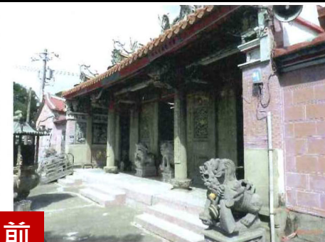
三川殿前檐緊急支撐施工前
