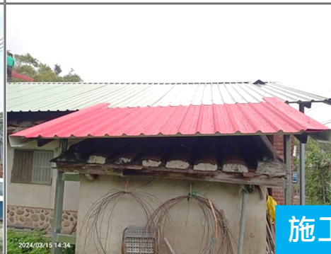
8. 外廁所屋頂保護鋼架 2.3M*3.4M
