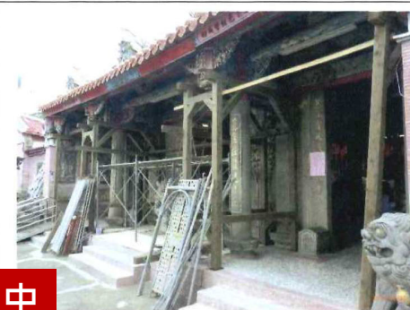
三川殿前檐緊急支撐施工中
