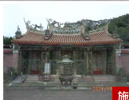
三川殿前檐緊急支撐施工中
