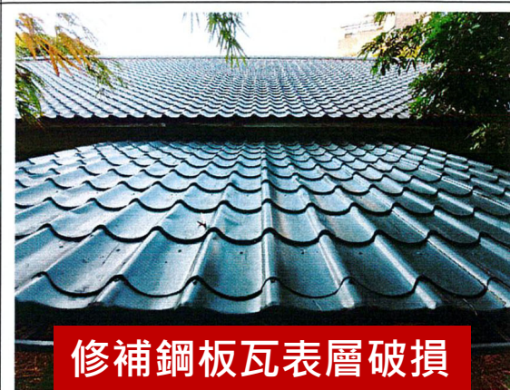
車寄屋面施工後
