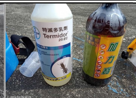
3. 外廁所、右稍間、右進間、入口門樓舊木料白蟻藥劑噴塗(噴塗三次)·113.3.19日第二次
