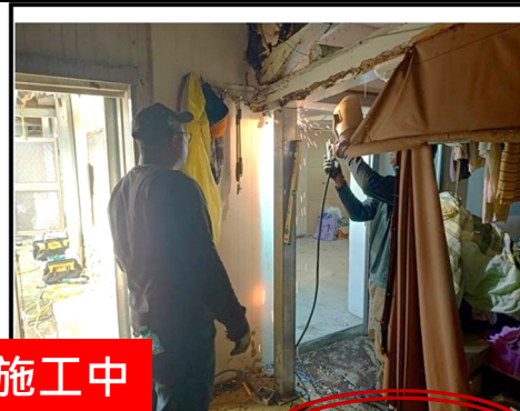
7. 右稍間、盡間補強 C 型鋼雙併立柱 1.8M
