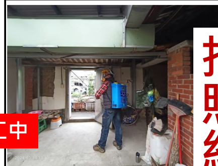
3. 外廁所、右稍間、右進間、入口門樓舊木料白蟻藥劑噴塗(噴塗三次)·113.3.19日第
