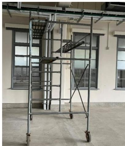
圖 10 移動式施工架護欄等安全設施不足
