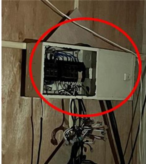
圖 20 臨時配電盤未配置中隔板
