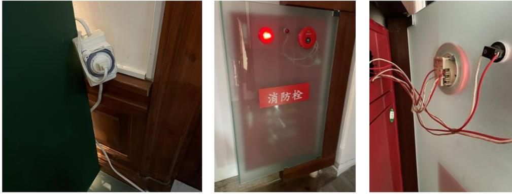
圖 13 電氣設備未固定及電線裸露情形
