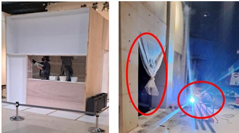
圖 46 切割粉塵及焊接應有通風作業
