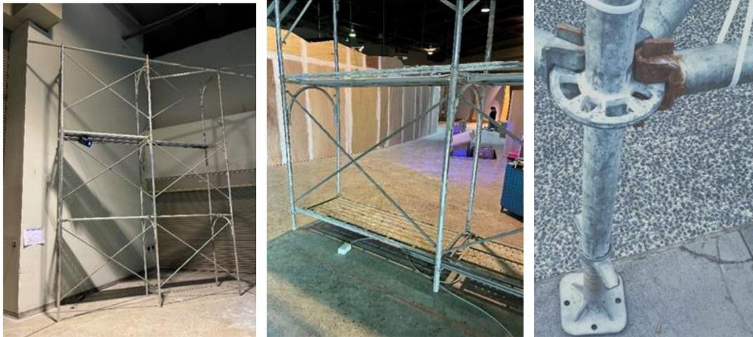
圖 31 施工架設置穩定性不足
