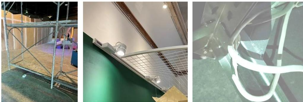
圖 21 室內拉線路帶電部位與金屬部分導通
