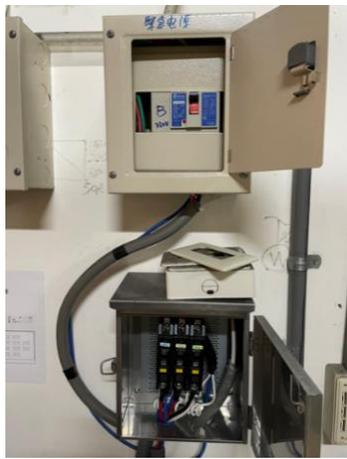
圖 14 緊急電源開關箱未有中隔板
