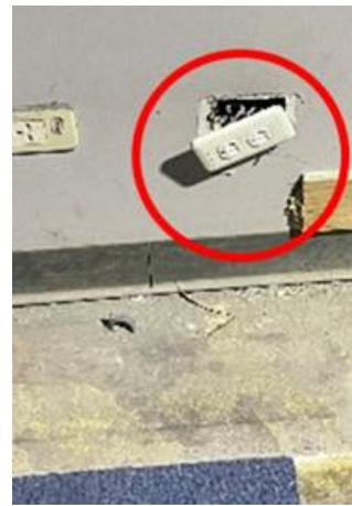
圖 15 電源插座未設置三孔或未固定
